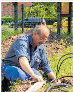
Sieht zwar noch ein wenig unübersichtlich aus, doch Elektromeister Fritz Ketzler verstromt das Gelände mit Übersicht – insbesondere das Bergbau-Denkmal.
