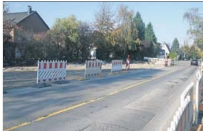
Seit Mai vergangenen Jahres ist die Moerser Straße auf Höhe Rumelner Markt Baustelle. Foto: Archiv/TV
