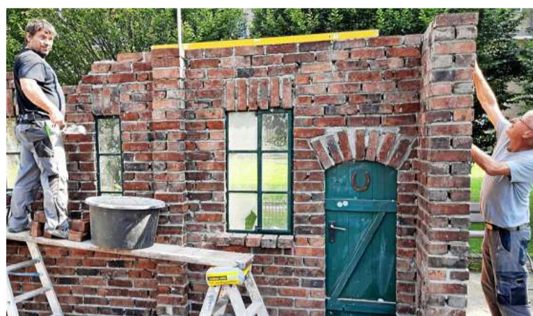
Noch ist es ein Rohbau, doch schon bald soll die Remise im Open-Air-Museum Rumeln-Kaldenhausen fertig sein.
