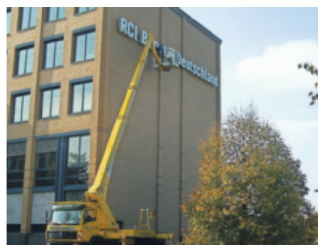
Ob Fassaden-, Autobeschriftung oder Reklameschilder in unübersehbarer Höhe: Wolfgang Pohl ist auch unter dem Dach der Nietiedt GmbH weiterhin Ihr Spezialist für Außendarstellung – natürlich auch für den Privatbereich. Fotos: privat
