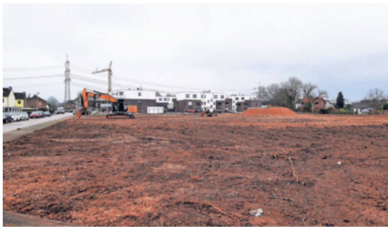
Dezember 2020: Die GEBAG lässt den Worten Taten folgen und das Grundstück der ehemaligen Sonderschule räumen. Bald werden die Steinbau und die GEBAG hier Wohnraum schaffen. Foto: Ferdi Seidelt
