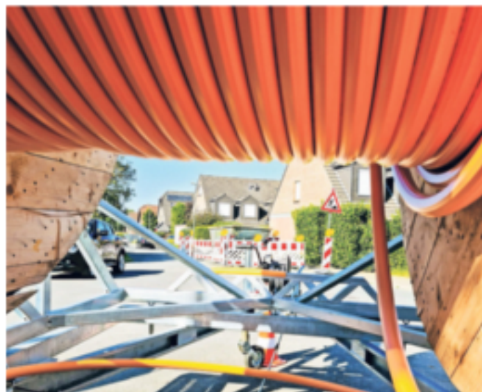
Der Ort Rumeln-Kaldenhausen auf dem Weg in seine digitale Zukunft. Der E.ON-Netzbauer Westconnect GmbH hat mit den Verlegearbeiten, hier in der Eurobau-Siedlung, begonnen. Foto: Ferdi Seidelt
