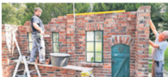
Fleißig wird an der Bauernremise gearbeitet. Foto: Seidelt
