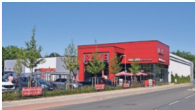
REWE Johann und die integrierte Backstube von MALZERS sorgen für hochqualitative Vollversorgung an der Rathausallee 11 in Rumeln. Fotos: TV
