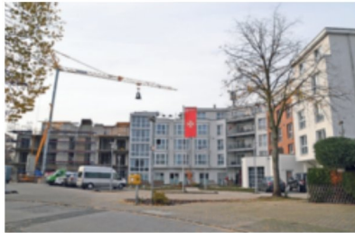
Das Malteserstift Veronika-Haus in Kaldenhausen bekommt derzeit einen neuen Anbau für „Wohnen mit Service“.
