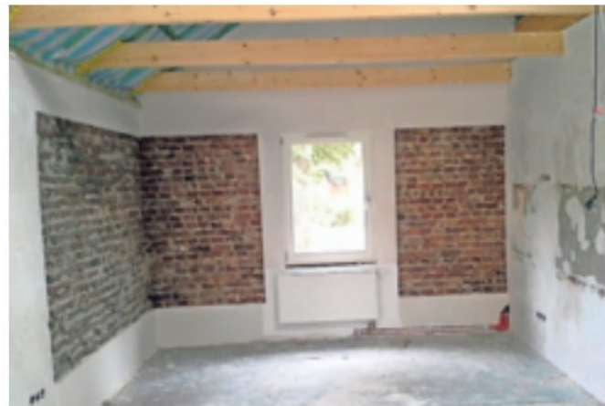
Das alte Mauerwerk soll auch im Inneren sichtbar sein. Jeder noch so individuelle Wunsch ist für Dietmar Liebig eine willkommene Herausforderung. Foto: privat
