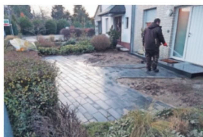
Auch Pflasterarbeiten werden professionell ausgeführt. Eine anschließende Bepflanzung rundet den Vorgarten gelungen ab.
