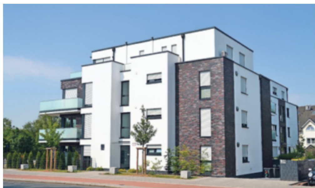
Die moderne Wohnanlage an der Düsseldorf Straße 36 in Rumeln ist die aktuelle Visitenkarte der Drite-Brink Baurträger GmbH. Foto: TV
