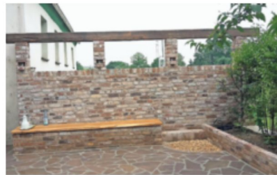
Jeder noch so individuelle Wunsch ist für Dietmar Liebig eine willkommene Herausforderung. Terrassengestaltung mit Feldbrandmauerwerk und Boden aus Naturstein-Bruch. Foto: privat
