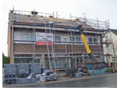
Dachsanierung eines Mehrfamilienhauses durch die Nowak Bedachungs GmbH.
