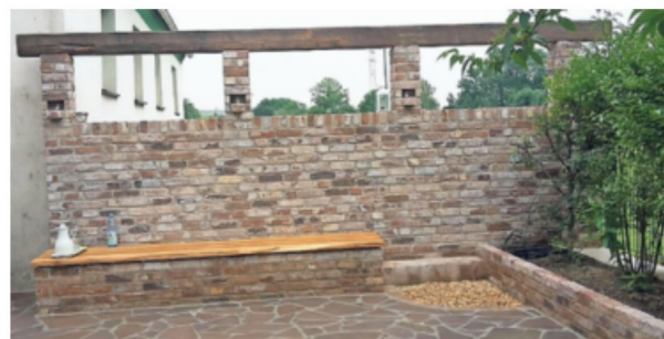
Jeder noch so individuelle Wunsch ist für Dietmar Liebig eine willkommene Herausforderung. Terrassengestaltung mit Feldbrandmauerwerk und Boden aus Naturstein-Bruch. Foto: privat
