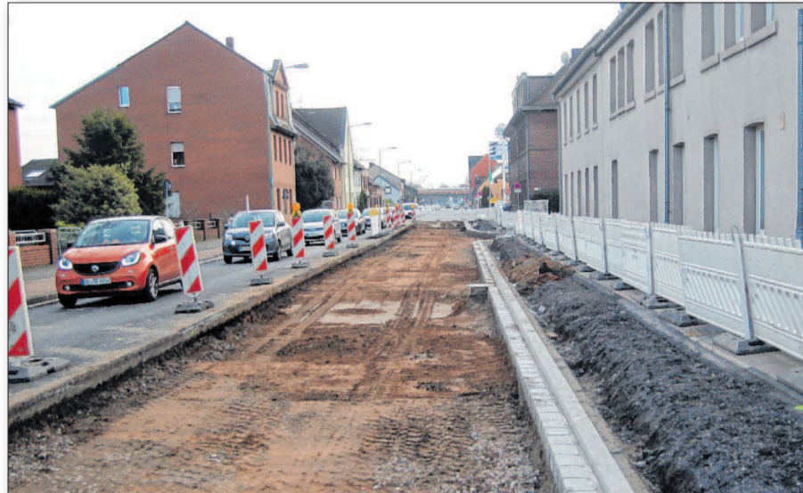
Höhe Blechwarenfabrik, Richtung Uerdingen. Noch ist nicht erkenntlich, dass schon in wenigen Tagen die nervenaufreibende Dauerbaustelle in Rumeln-Kaldenhausen passé sein wird. Foto: Ferdi Seidel
