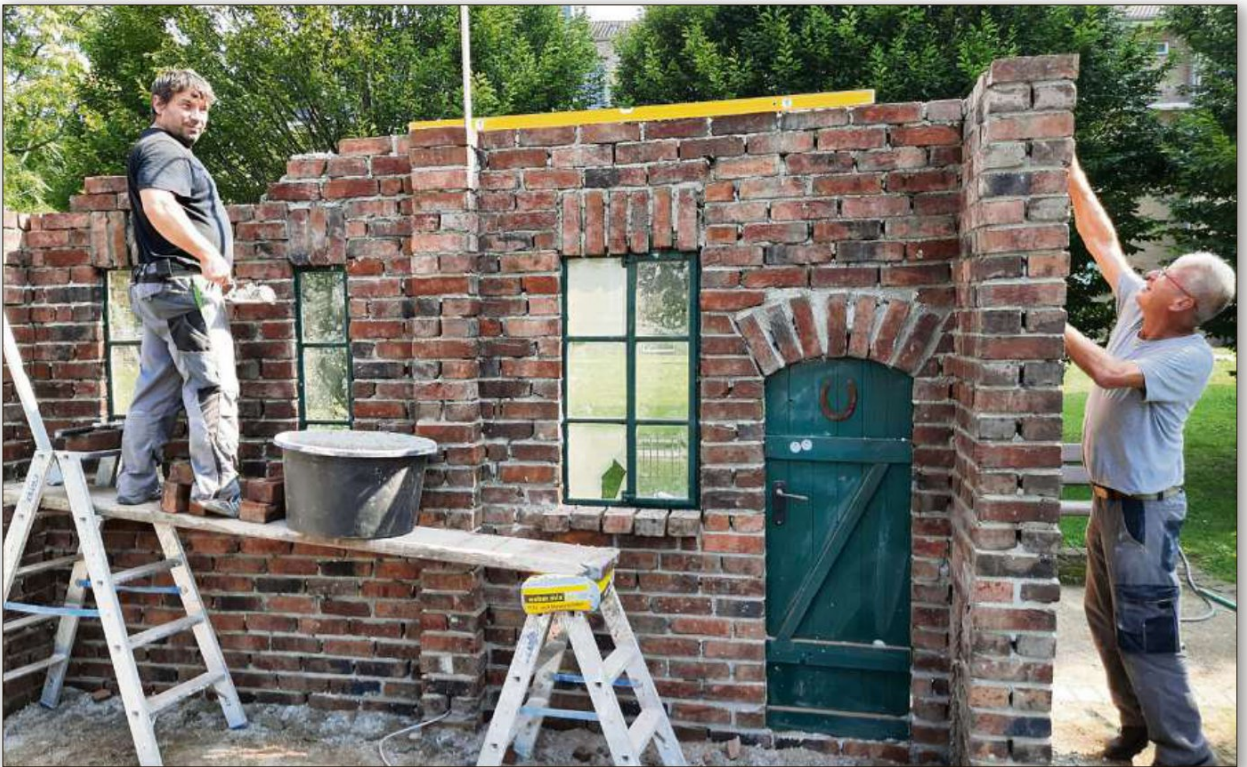
Noch ist es ein Rohbau, doch schon bald soll die Remise im Open-Air-Museum Rumeln-Kaldenhausen vom bäuerlichen Leben anno dazumal kündigen. Eine Einweihungsfeier ist in Planung. Foto: Ferdi Seidelt
