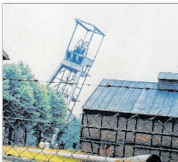
1973 war auch in Rumeln endgültig Schicht im Schacht. Nach der letzten Schicht am 29. Juni dauerte es nur Monate, bis der Förderturm in Rumeln flachgelegt wurde. Heute erinnern einige Straßennamen, der Schachtdeckel sowie einige Schienen am Volkesberg an den Bergbau.
